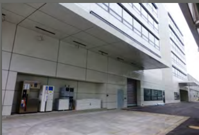
Osteingang mit Tanksäulen
