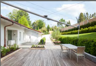
Rückansicht Gebäude mit Terrasse
