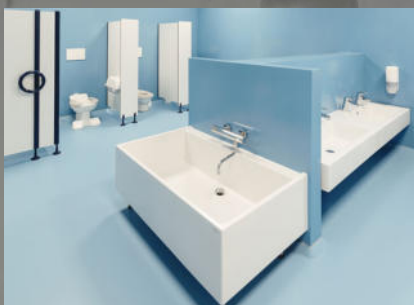
Waschbecken in den Toiletten
