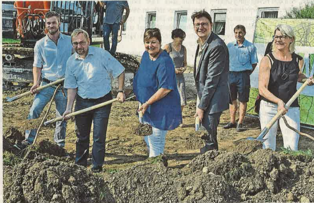
Offizieller Spatenstich an der Adalbert-Stifter-Straße; v.li.: Simon Kopf, Bauleiter, Blankenhagen und Cohrs Ingenieure; Bürgermeister Rolf Beuting, Landrätin Andrea Jochner-Weiß, Markus Kleinen, Wohnbau GmbH Weilheim und Architektin Annette Rill.
