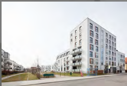
Seitenansicht von der Straße
