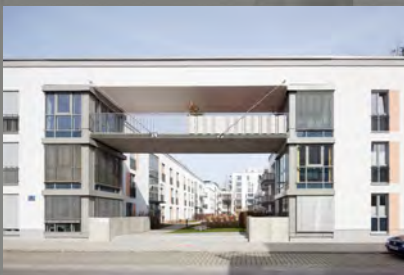
Blick in den Innenhof mit Verbindungsbrücke
