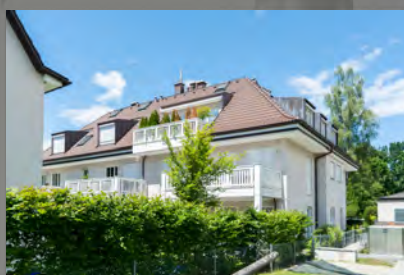
Ansicht vom Innenhof
